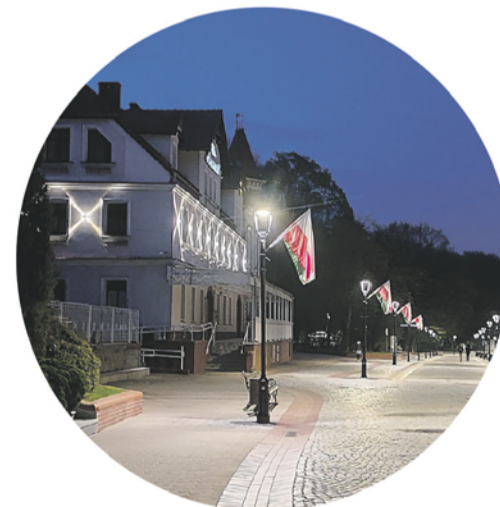
Wymiana oświetlenia zainstalowano 800 lamp LED
